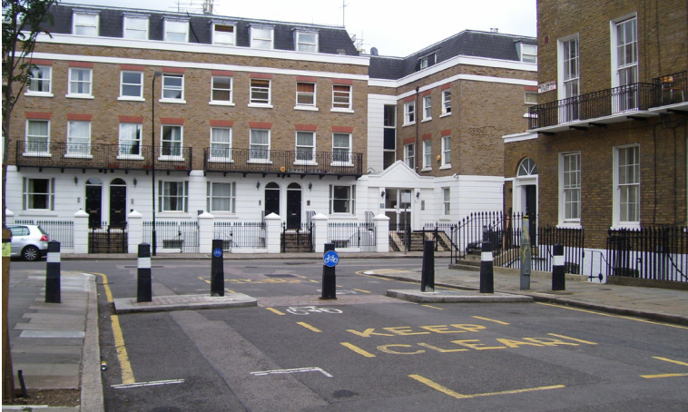
Fig. 42a Fecho parcial entre zonas. É vedada a passagem de veículos e permitida a passagem de peões e velocípedes. (Londres, Inglaterra)
