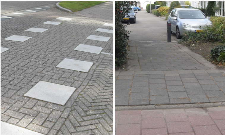
Fig. 97 Uso do mesmo material com diferentes orientações ou colorações, criando contraste visual ou níveis de rugosidade diferenciados
