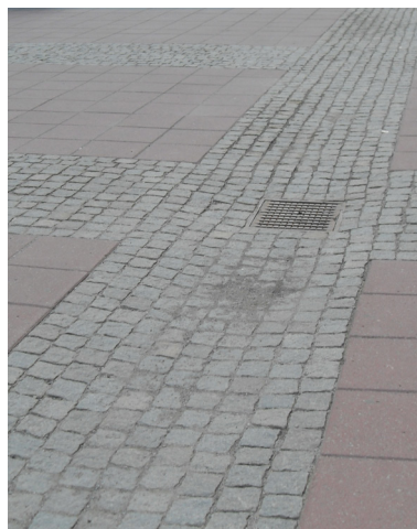
Fig. 117 Valetas revestidas de pequena dimensão associadas a sistema de drenagem urbana (Estocolmo, Suécia)
