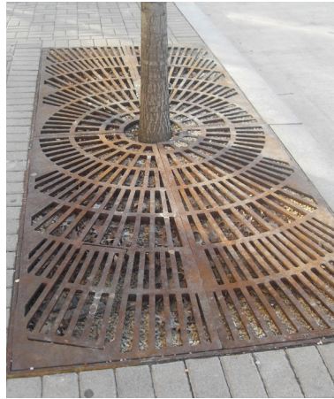
Fig. 106 Tratamento de caldeiras de modo a evitar quedas dos peões
