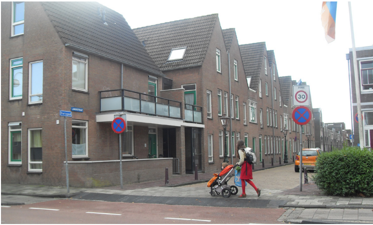
Fig. 50 Continuidade altimétrica no passeio de entrada numa zona 30 (Leiden, Holanda)
