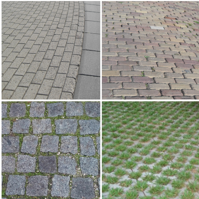
Fig. 98 Exemplos de pavimentos permeáveis
