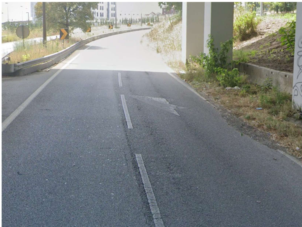
Figura 3: Via panorâmica Eng. Edgar Cardoso, por baixo da ponte da Arrábida
